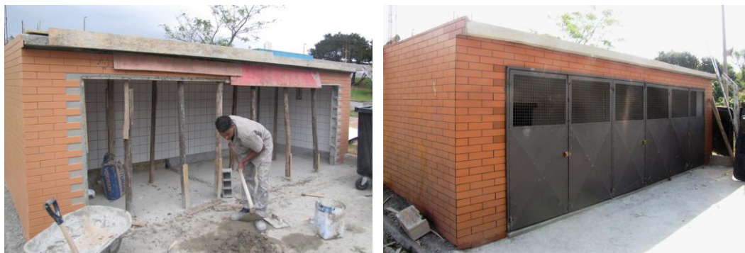
Construção da lixeira na P2
