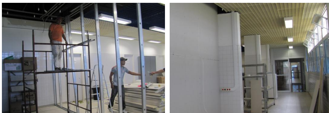
Obras do Biotério
